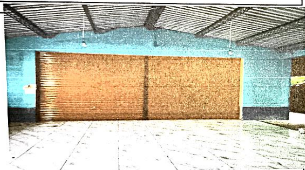
Foto 3: SE COLOCO PISO CERAMICA EN EL AULA No.02
