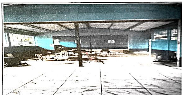
Foto 4: SE COLOCO PISO CERAMICA EN LOS TRES AULAS DEL CENTRO EDUCATIVO
